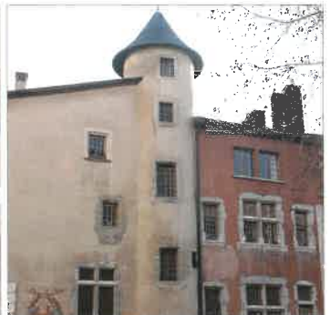
Maison du XVe siècle en maçonneries de moellons enduits, croisées de pierre et escalier en tourelle. Cette distribution par un escalier hors-oeuvre, sur rue ou sur cour, perdurera jusqu'au XVIe siècle.
