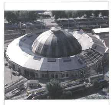
La Rotonde du dépôt des machines de la gare de triage, fleuron de l'architecture métallique de type Eiffel, voit le jour en 1908. Cible des bombardements de 1944, elle est inscrite à l'Inventaire Supplémentaire des Monuments historiques.
